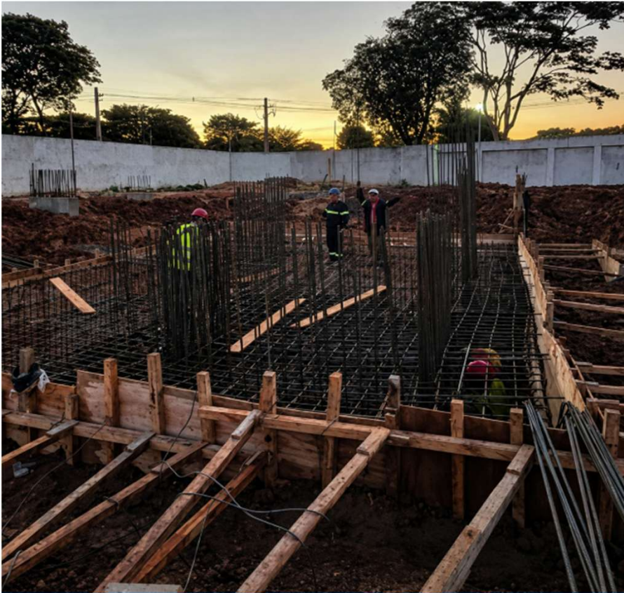
Armadura de cabezales
